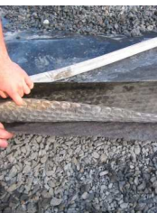
Prüfung und Sicherung der Basisabdichtung
