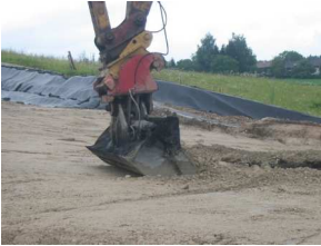
Baggerarbeiten zur Profilierung des Zwischenlagers bis hin zum Altdeponiebereich
