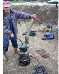
Pumpenaustausch Sickerwasserschacht
