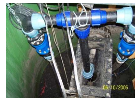
Pumpenanlage im Sickerwasserschacht
