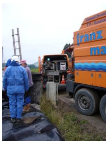
Mobiler Kamera- wagen mit Spül- wagen
