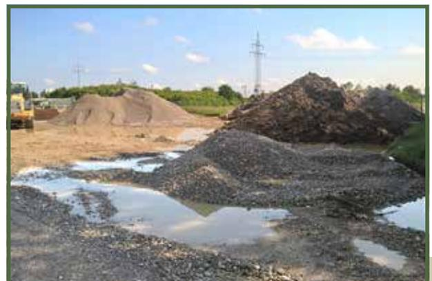
*Bild 1: Praxisbeispiel Bauvorhaben Gleisdreieck Fa. Schernthanner – erst wird der belebte Oberboden abgetragen und gesichert.*
