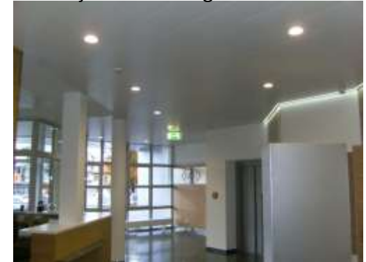
Umbau Eingangsbereich mit LED Downlight 12 Watt und Lichtband mit LED Strip
