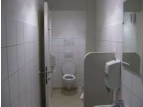
WC ohne Tageslicht mit Downlight 7 Watt
