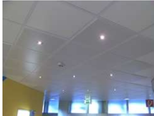
Eingangsbereich - Austausch 20 Watt Spot auf 4 Watt LED Spot
