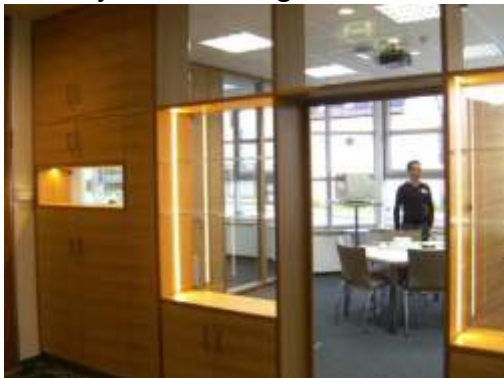
Bürraum: Vitrinnenbeleuchtung mit LED Strip Umrüstung der Rasterlampen 60 cm LED Röhren 8 Watt/Röhre
